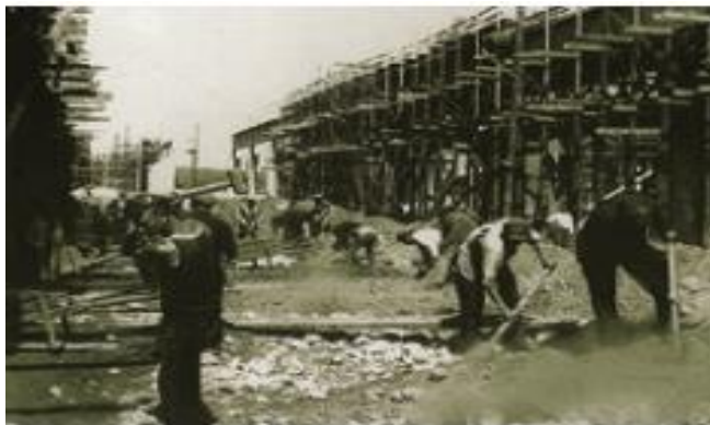
Строительство механического цеха № 6 на Новокраматорском машиностроительном заводе. 1932 г.
