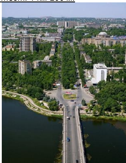
Мост по бульвару Шевченко
